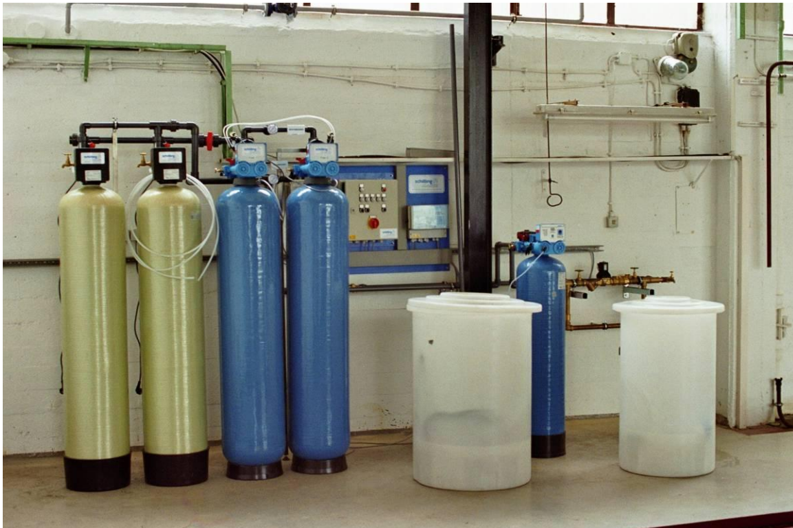
Blick auf die Umkehrosmoseanlage zur Erzeugung von enthärtetem Wasser
