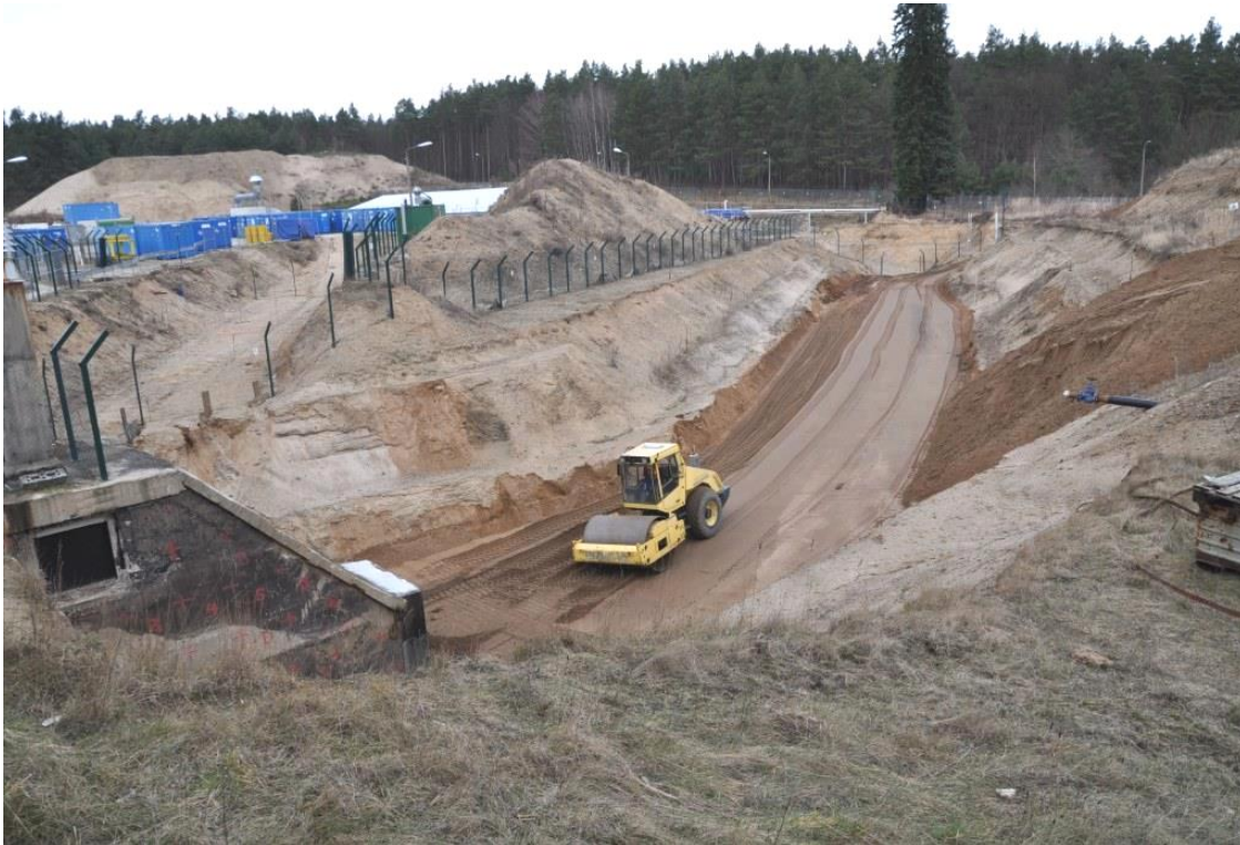
Verfüllen einer Baugrube des ALfR
