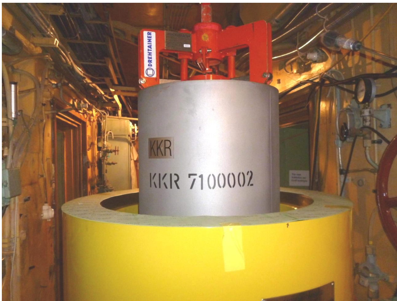
Einsetzen Filter in Mosaikbehälter als Vorbereitung für den Transport zum ZLN
