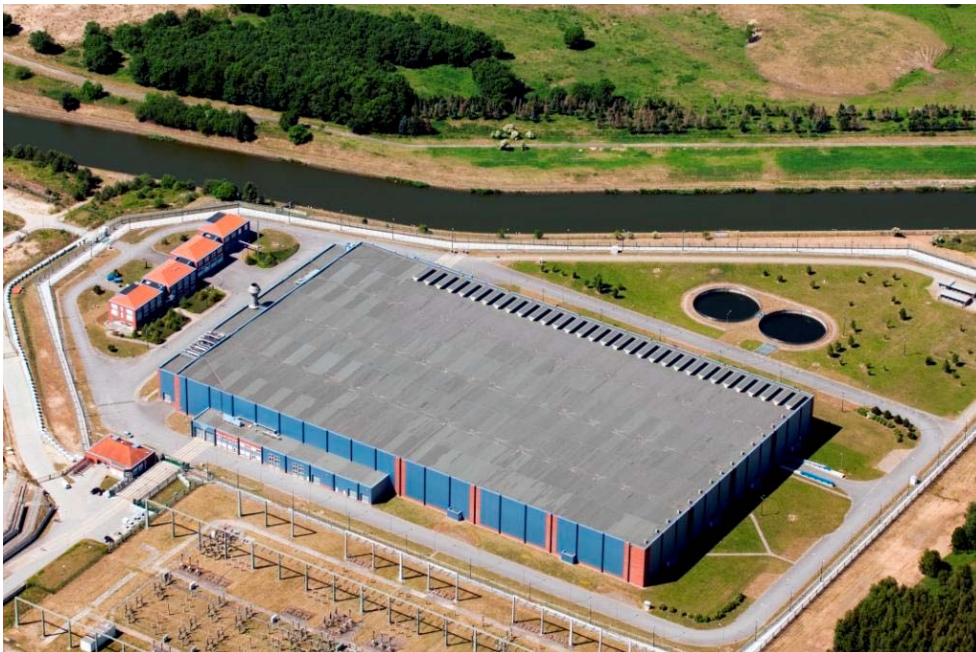
Zwischenlager Nord im Juni 2010
