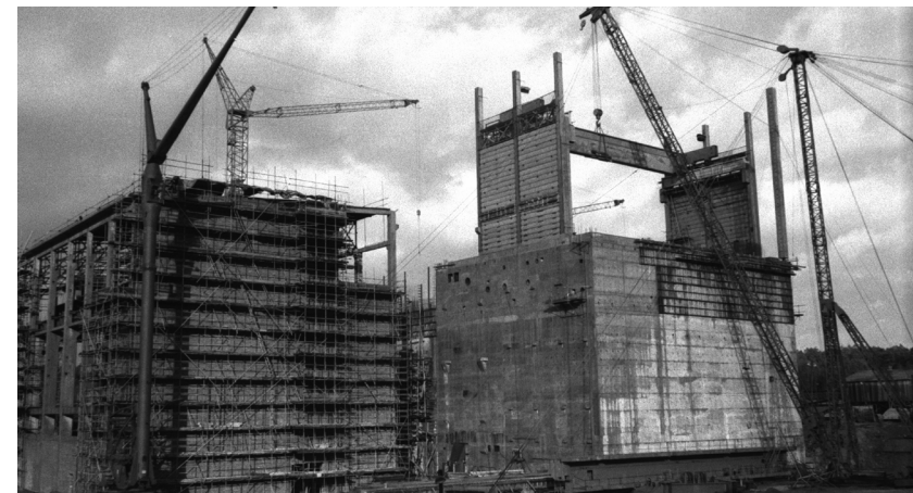
Bau der Hauptgebäude
