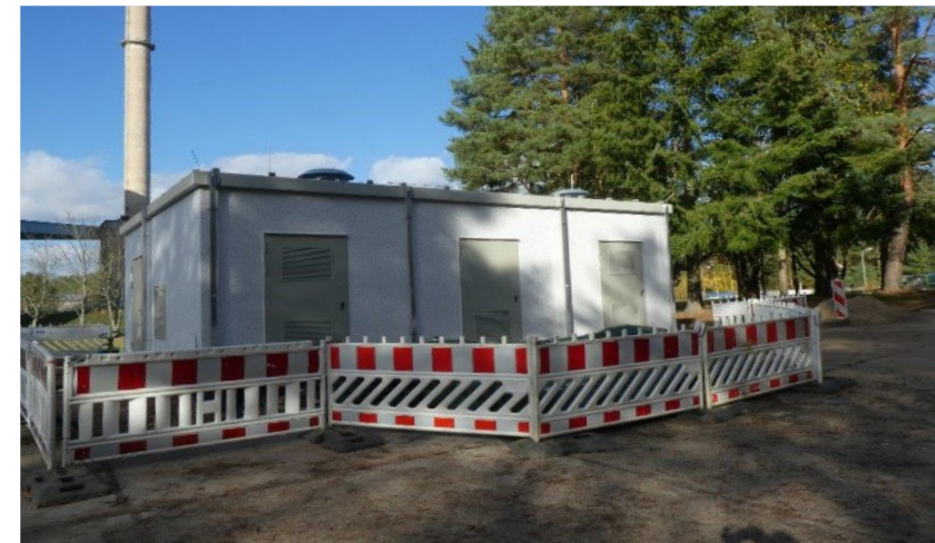
Begehbare Transformatorstationen TSt-I
