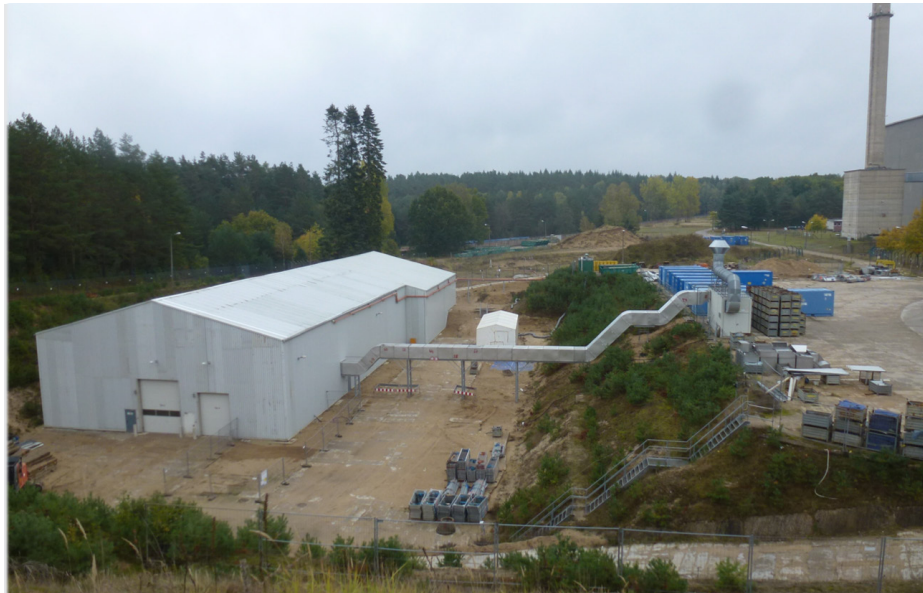
Außenansicht des eingehausten ALfR-flüssig mit Abluftcontainer
