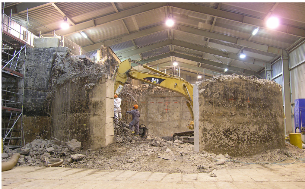
Rückbau ALfR-flüssig unter einer Schutzeinhausung
