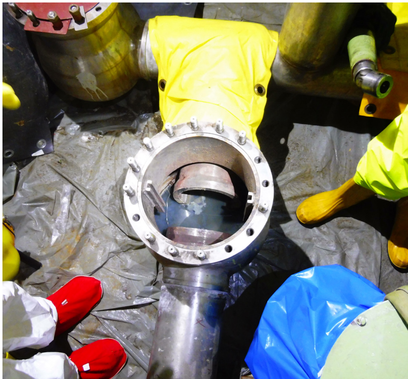
Arbeiten zur Reinigung der Spezial-Kanalisation KKR
