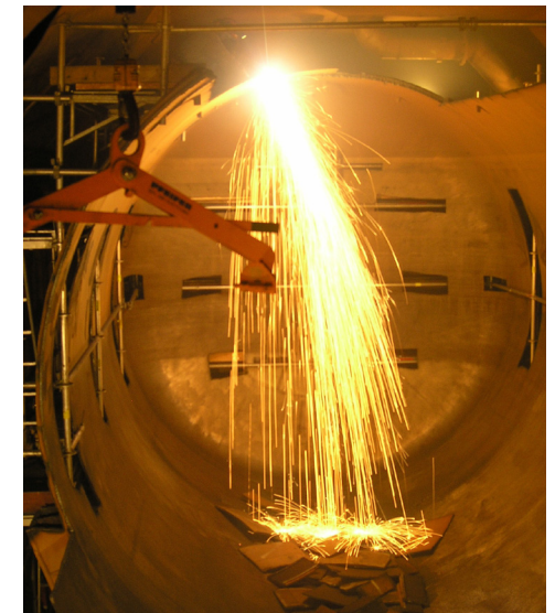
Zerlegung 200-m³-Behälter vor Ort
