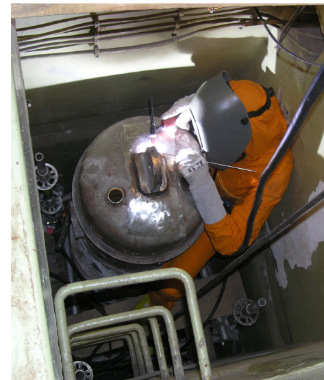
Demontage einer Verdampferanlage in der SWA
