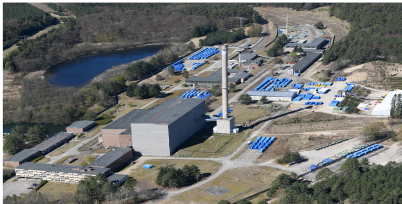
Gelände Kernkraftwerk Rheinsberg
