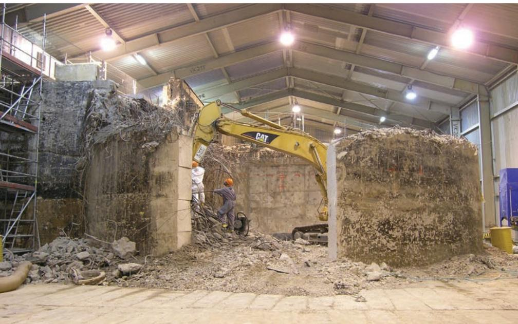
Rückbau ALFR-flüssig unter einer Schutzeinhausung
