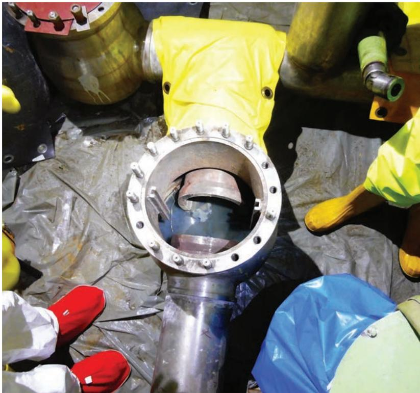
Arbeiten zur Reinigung der Spezial-Kanalisation KKR
