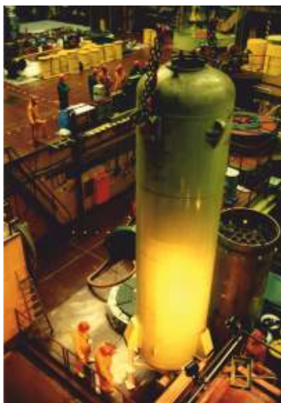
Ausbau eines Gasabklingbehälters
