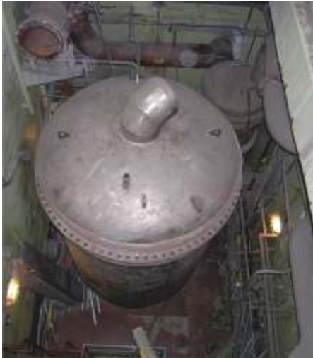
Demontage und Transportvorbereitung der Verdampferanlage
