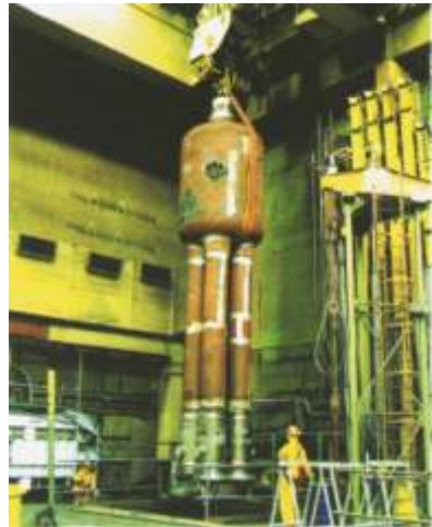
Ausbau eines Dampferzeugers
