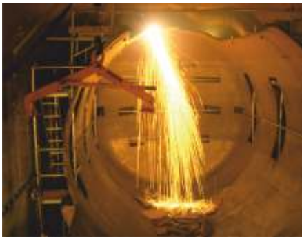
Zerlegung 200-m 3 -Behälter
