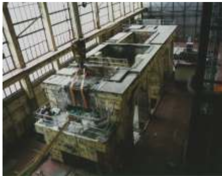
Rückbau des Turbinenfundaments
