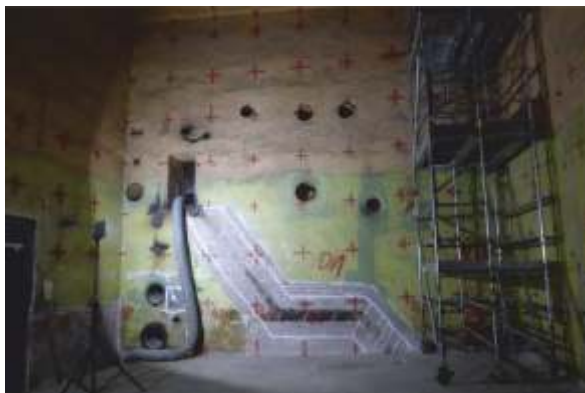
Messraster für radiologische Messungen nach dem Entkernen eines Behälterraumes
