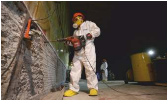
Abstemmen von radiologisch belastetem Beton
