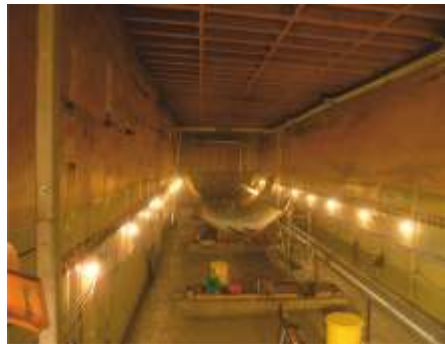
Zerlegung 1.000-m 3 -Behälter
