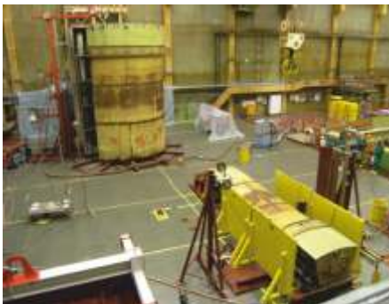
Betrieb Vor- und Nachzerlegeplatz RWB
