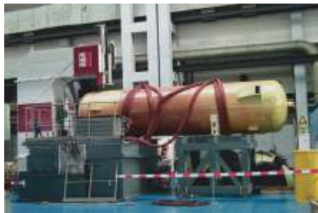
Gasabklingbehälter in der Zerlegewerkstatt
