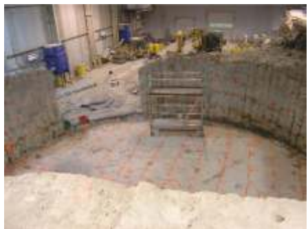
Abbruch ALfR-flüssig unter einer Einhausung
