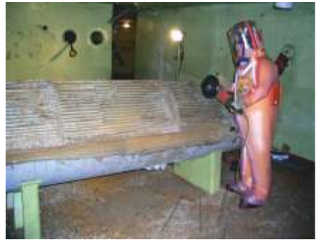
Zerlegung - Kühler
