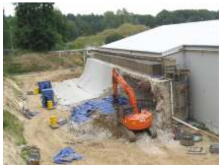
Teilabbruch der Behälterräume ALfR-flüssig ohne Schutzeinhausung
