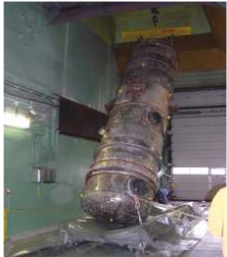
Demontage und Transportvorbereitung der Verdampferanlage
