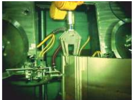
Zerlegung - Reaktorschacht in der NZS
