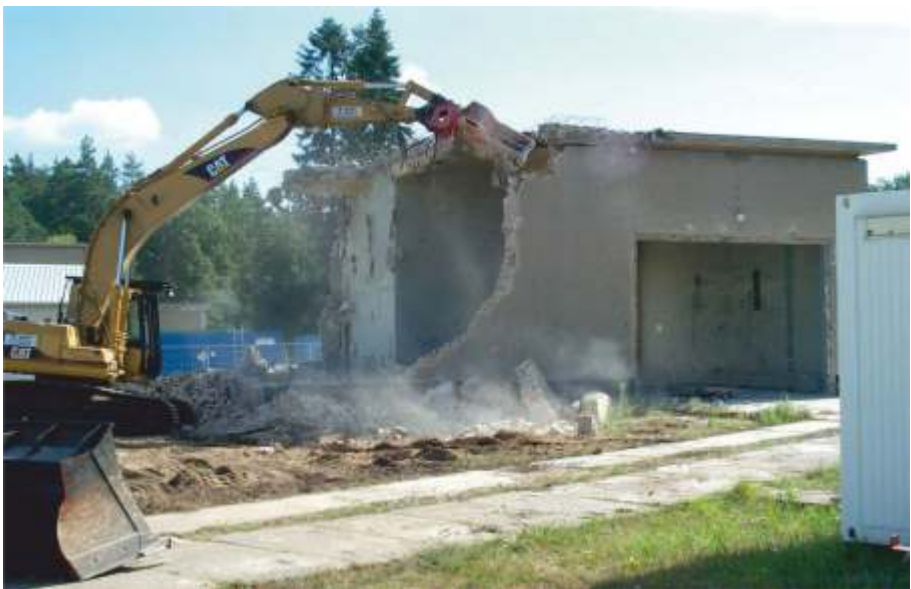
Abbruch Auto- und Containerwäsche
