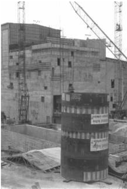
Bau der Hauptgebäude
