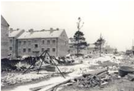
Bau der Kraftwerkssiedlung in Rheinsberg
