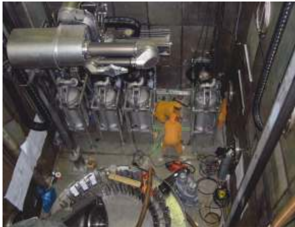
Errichtung Nasszerlegestation (NZS)
