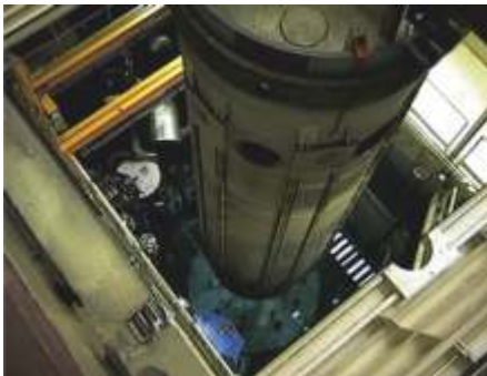
Transport - Reaktorschacht in die NZS
