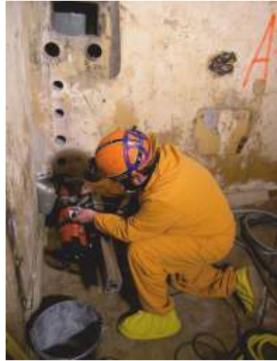
Entfernen von Wanddurchführungen
