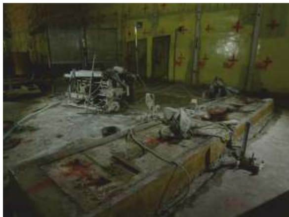
Heraussägen der Fundamente mittels Seilsäge
