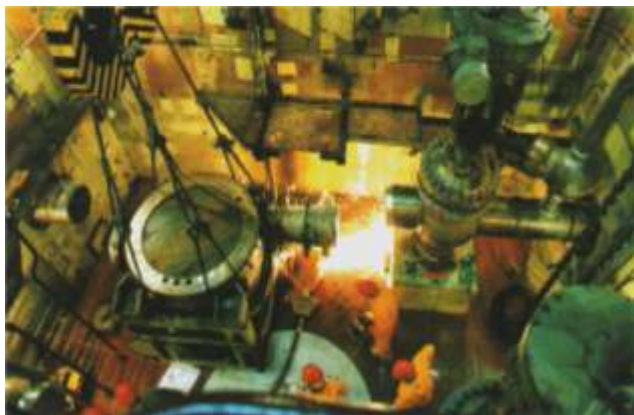
Ausbau des Pumpengehäuses einer Hauptkühlmittelpumpe
