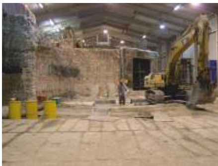
Abbruch ALfR-flüssig unter einer Einhausung
