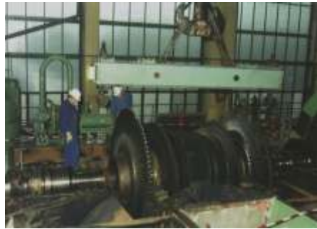
Turbine - Ausbau des Niederdruckläufers
