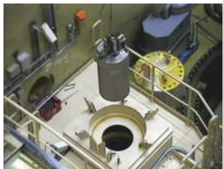
Transport eines Einsatzkorbes mit Abschirmglocke
