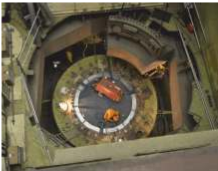
Heraussägen - Kabelringträger/Schutzplatte
