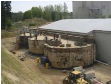
Freimessung der Behälterräume ALfR-flüssig
