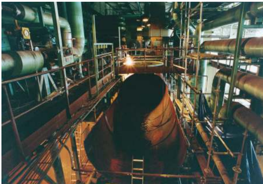
Demontage der Speisewasserbehälter
