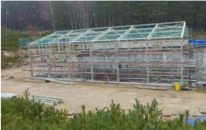
ALfR - 2016 letzter Abbruchabschnitt der Baustruktur
