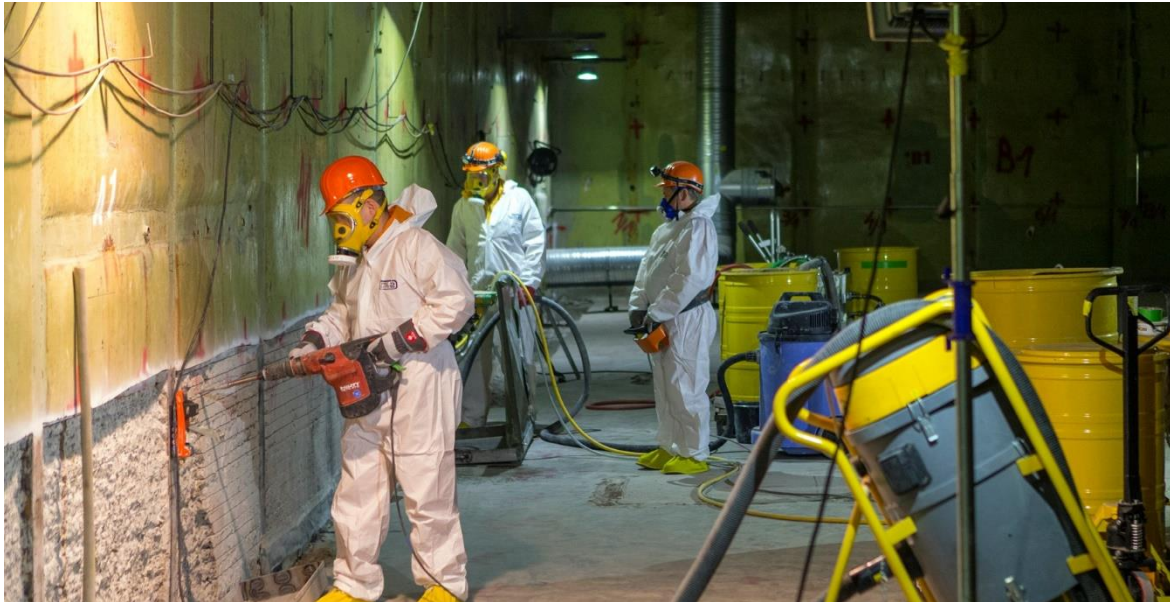
Arbeiten im Kontrollbereich KKR
