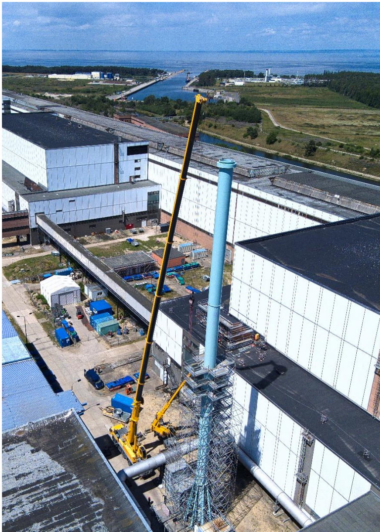
Neu errichtete Externe Abluftanlage Nord I mit neuem Kamin
