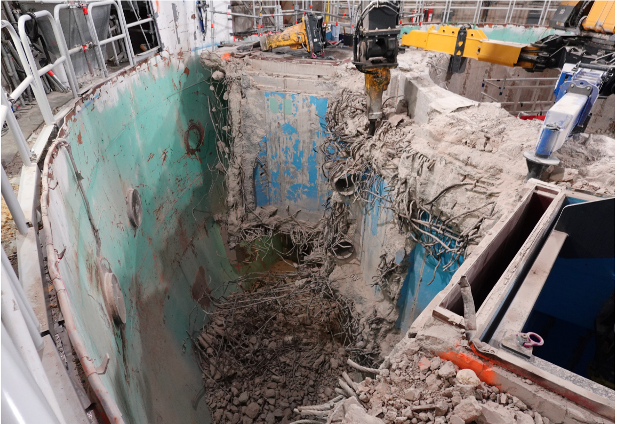
AVR: Demontage der Betonstrukturen im Schutzbehälter/Jülich
