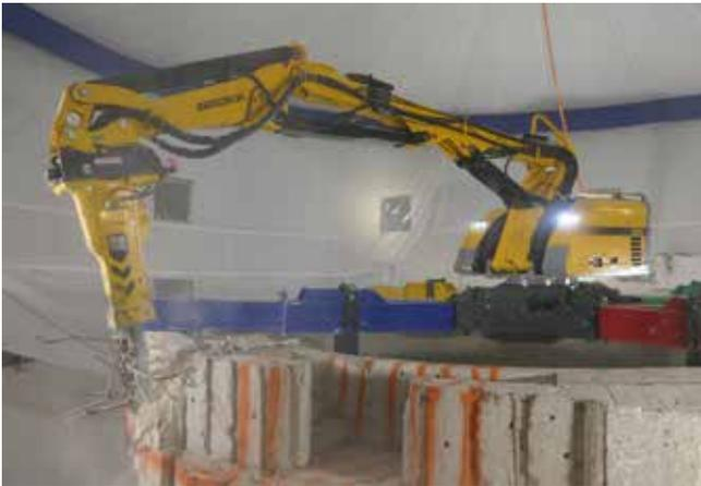
Betonabbruch mit Spinnenbagger
