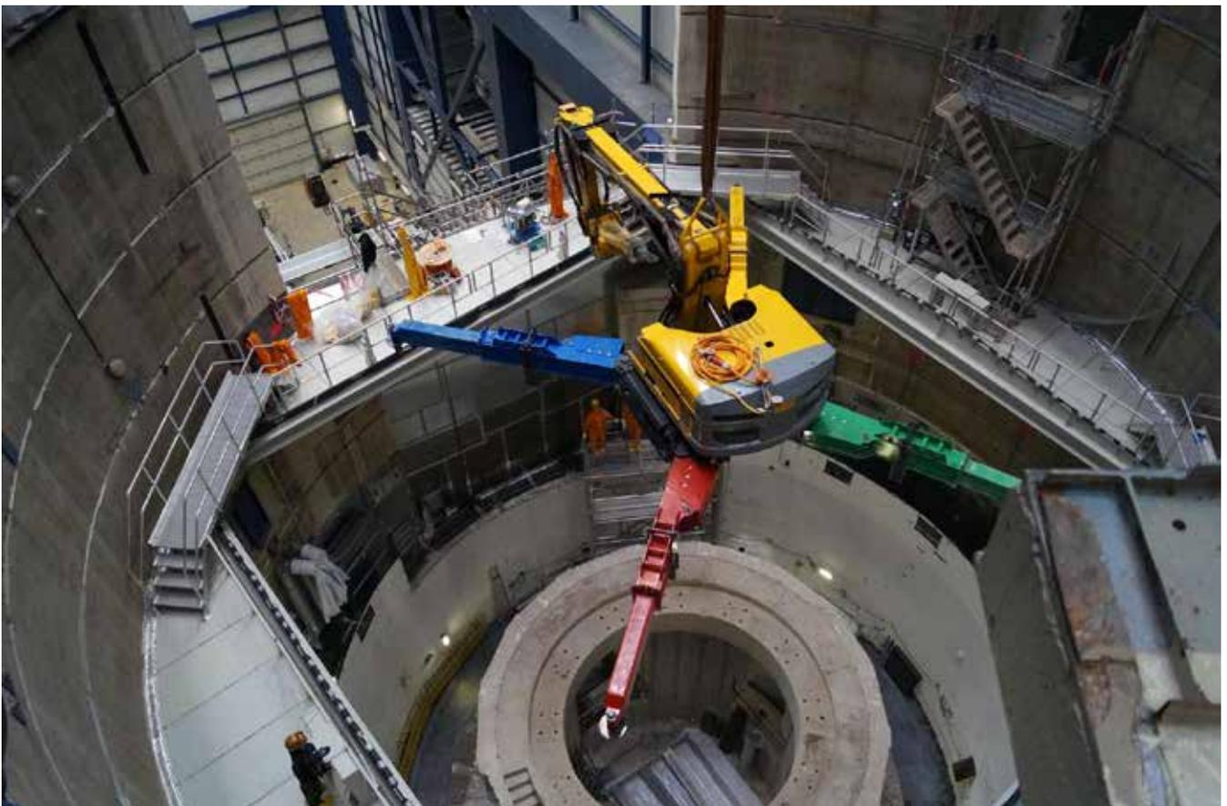
Einschleusen des Spinnenbaggers in den AVR-Schutzbehälter
