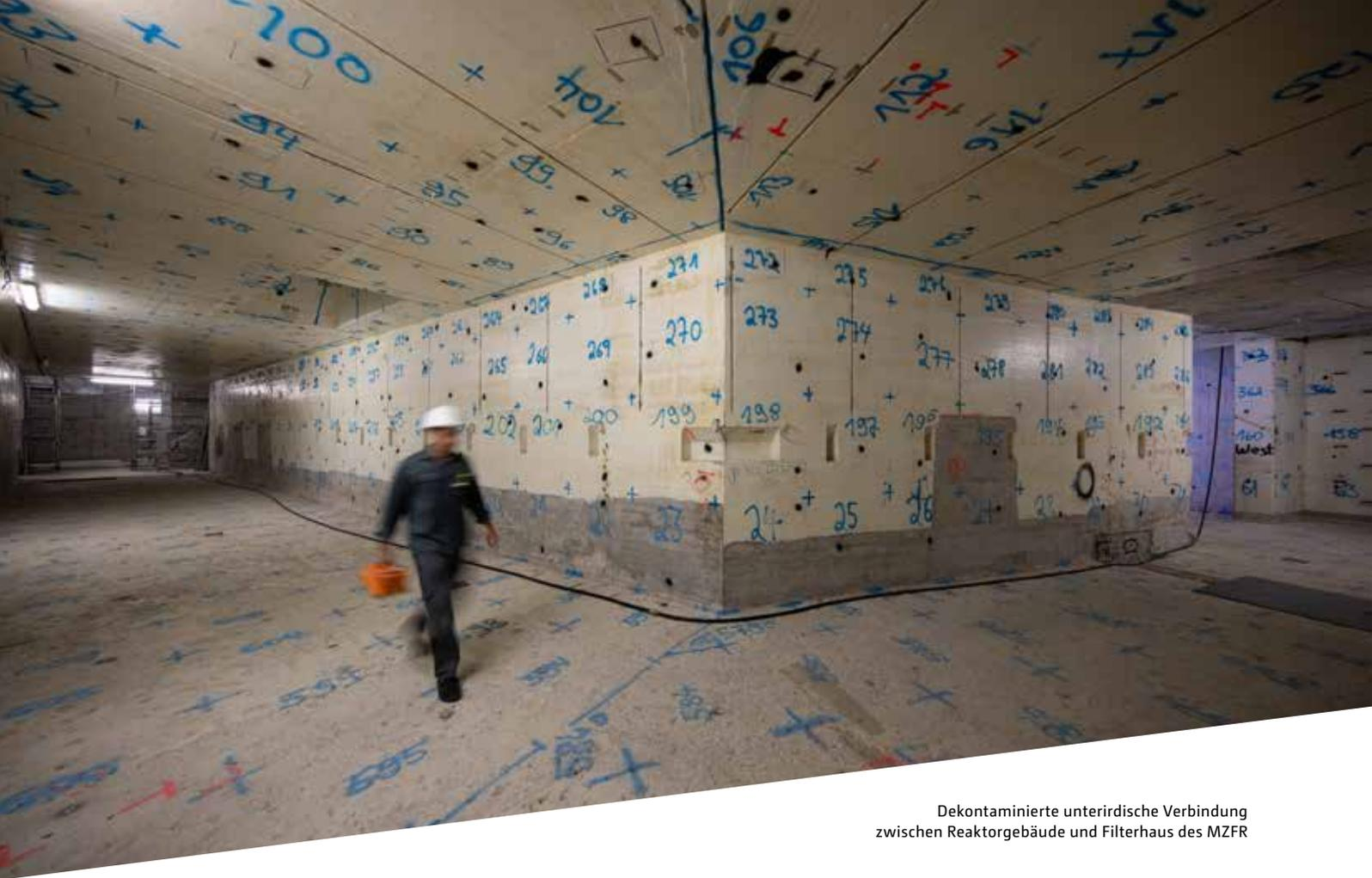
Dekontaminierte unterirdische Verbindung zwischen Reaktorgebäude und Filterhaus des MZFR
