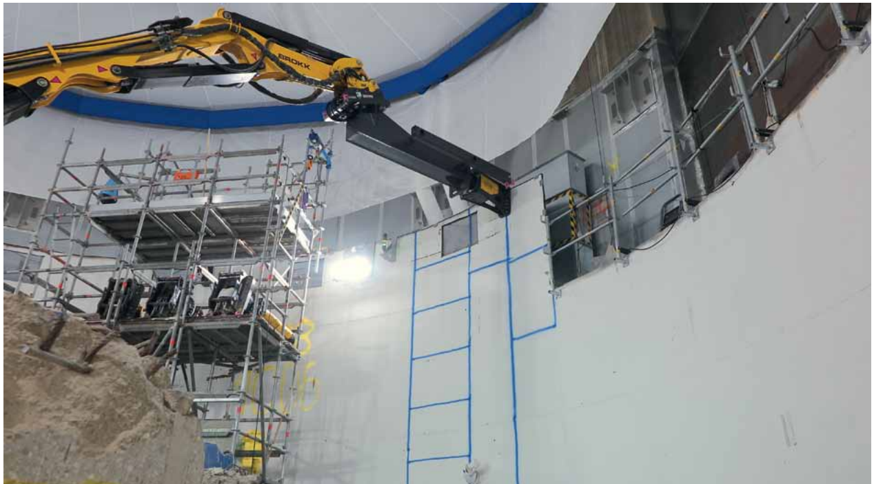
Demontage der AVR-Schutzbehälterwand von +19,0 m bis +11,5 m mittels Tankschneider /Jülich
