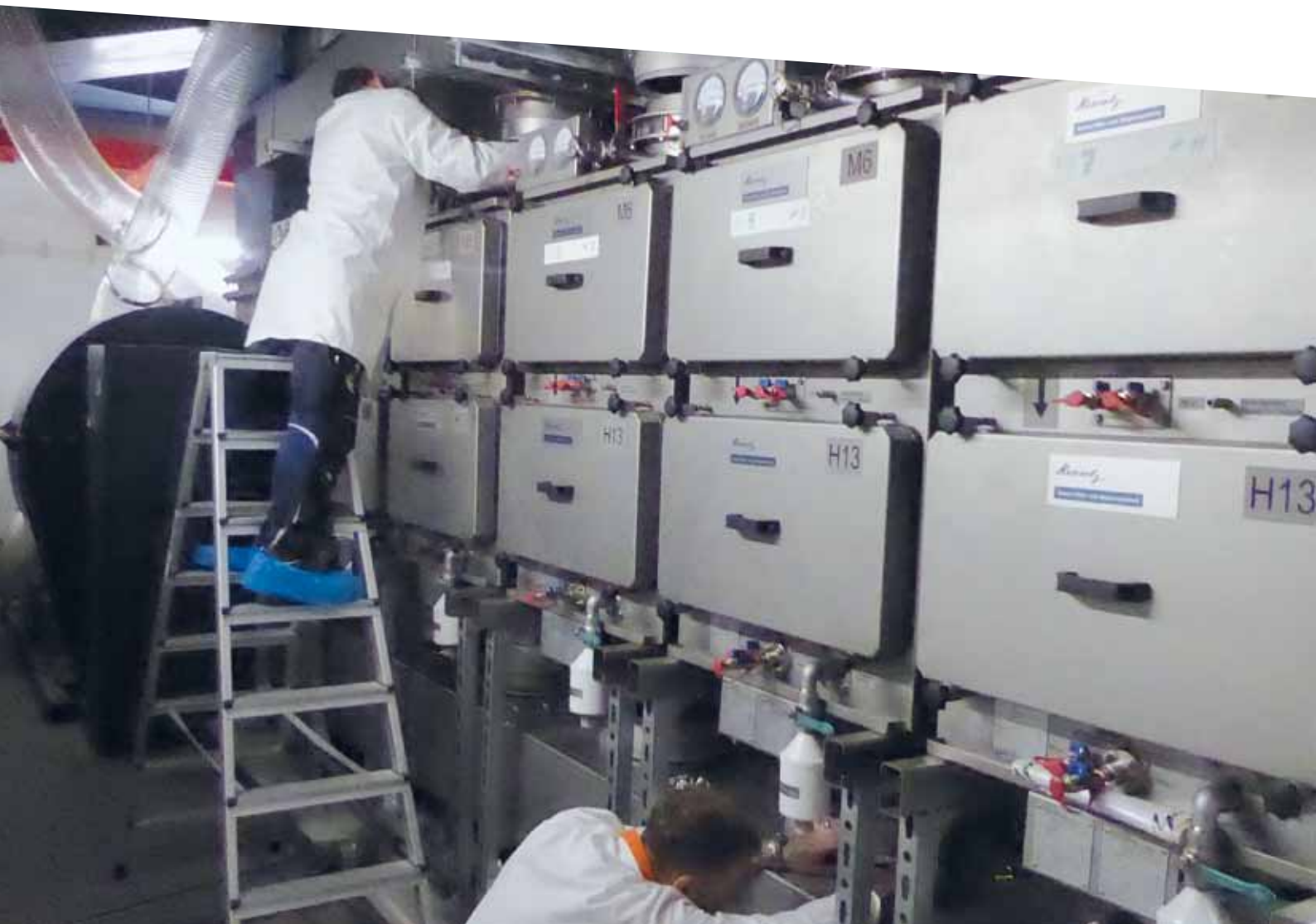
Montagearbeiten an der Abluftfilteranlage der GHZ/Jülich
