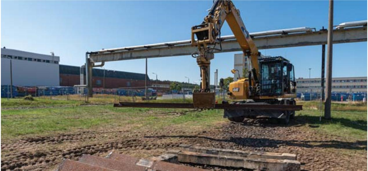
Rückbau von Gleisanlagen am Standort Lubmin/Rubenow
