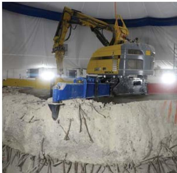
Abbruch der Betonstrukturen im AVR-Schutzbehälter /Jülich
