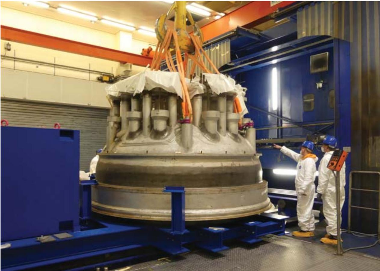
Vorbereitungen zur Zerlegung des letzten Reaktordeckels im Caisson 4 des ZLN/Rubenow
