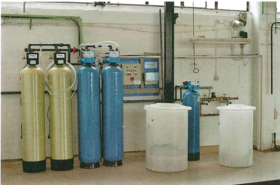
Anlage zur Erzeugung von enthärtetem Wasser
