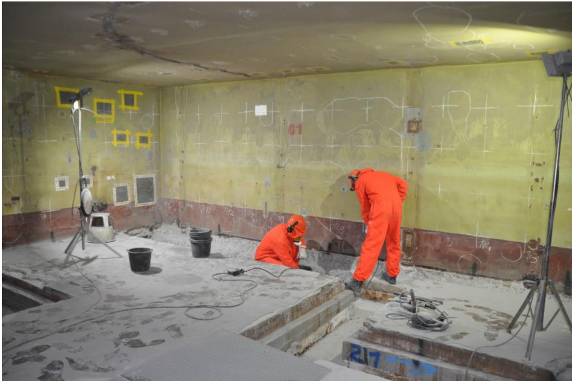
Arbeiten im Kontrollbereich KKR
